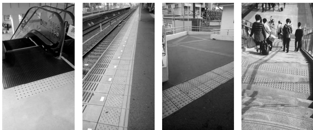
Рис. 7. Грамотное использование тактильной плитки в городской среде зарубежья
