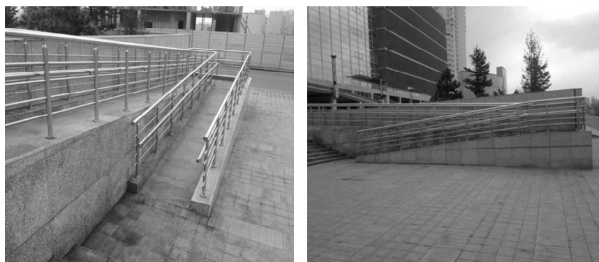
Рис. 3. Удачное решение пандуса (на входе в Мариинский театр, ул. Фастовская 20)
