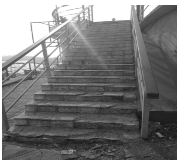
Рис. 8. Лестница к видовой площадке «Орлиное гнездо»
