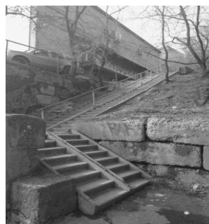
Рис. 9. Лестница вдоль фуникулера
