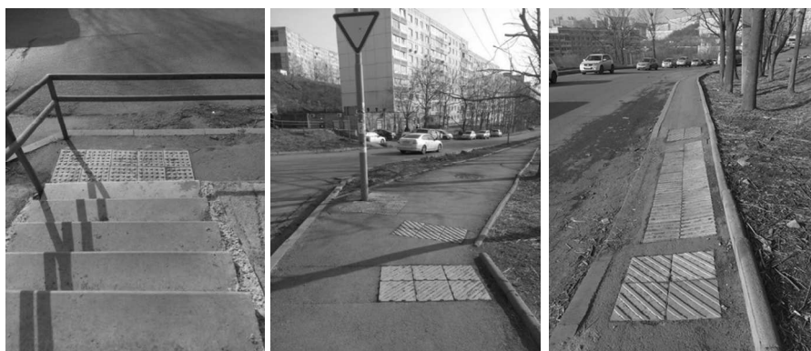
Рис. 4. Пример размещения тактильной плитки в местах перемещения пешеходов (Остановка Панфилова)
